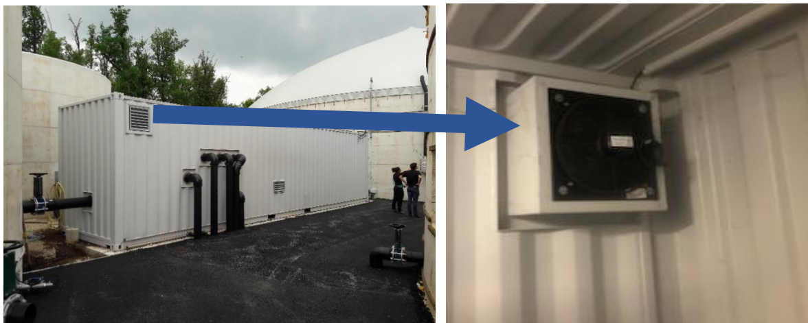
Figure 22 Représentation de la ventilation du Local process
